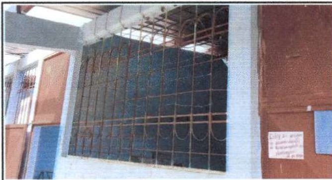
Foto 4: MÓDULO 1 AULAS: VENTANAS: Mantenimiento a balcones de metal.
