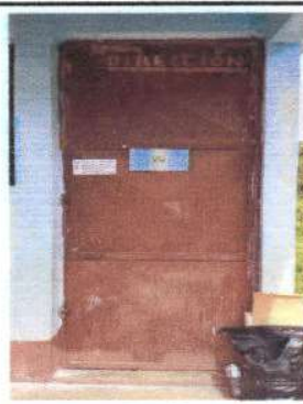
Foto 2: MÓDULO 1 AULAS: PUERTAS DE METAL: Mantenimiento a estructura ( lijado ,cambio de tubo, cepillado, sujeciones, aplicación de pintura), Cambio de chapa.
