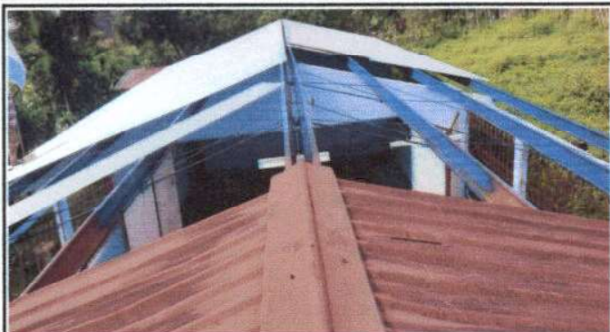
Foto 1: MÓDULO 1 AULAS: CUBIERTA DE LÁMINA: Sustitución de lámina, por lamina troquelada aluzinc calibre 26, Sustitución de capote para lámina troquelada, Sustitución elementos de fijación.
