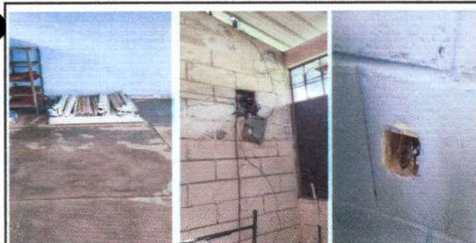
Foto 5: MÓDULO 1 AULAS: REPARACIÓN DE SISTEMA ELÉCTRICO: Sustitución de plafoneras, Sustitución de focos ahorradores, Sustitución de interruptores dobles, Sustitución de tomacorrientes
