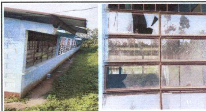
Foto 3: MÓDULO 1 AULAS: VENTANAS: Sustitucion de vidrios.
