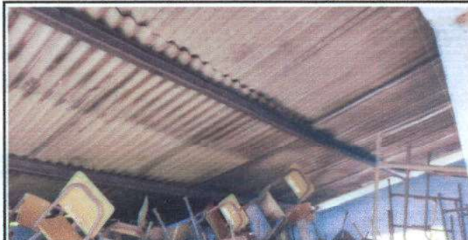
Foto 6: MÓDULO 2 COCINA: CUBIERTA DE LÁMINA: Sustitución de lámina troquelada aluzinc calibre 26, Mantenimiento a estructura de soporte de metal.
